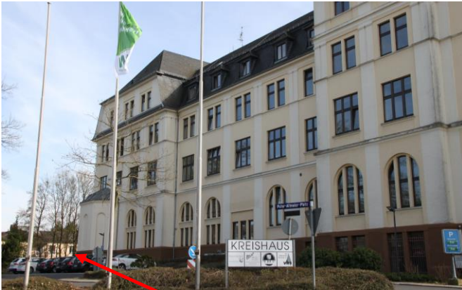
Technikanbau mit Kühltank
