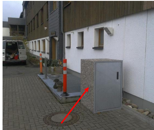
Probenkühltank an der Gebäudenordseite in einer Waschbetonbox
